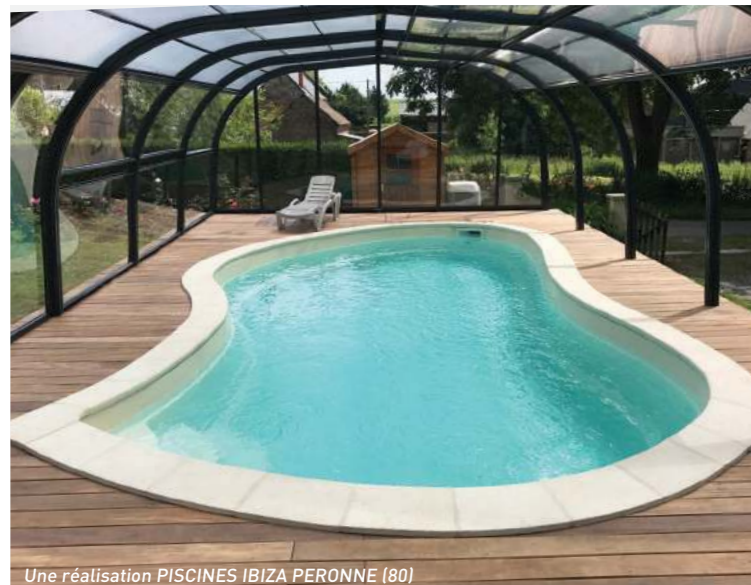
Une réalisation PISCINES IBIZA PERONNE (80)
